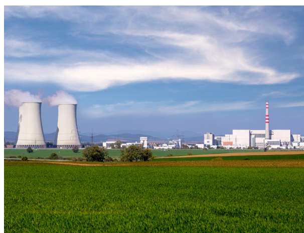
Bohunice NPP in Slovakia ©Slovenské elektrárne.jpg
